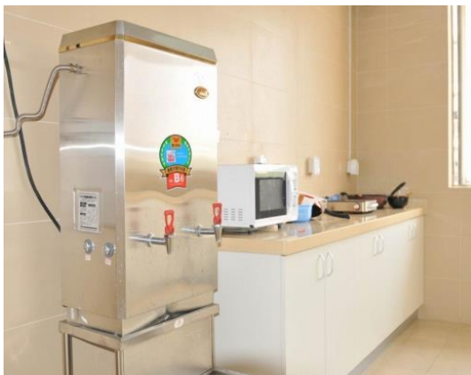
华佗路 280 弄 18 幢 22 号公寓楼厨房
